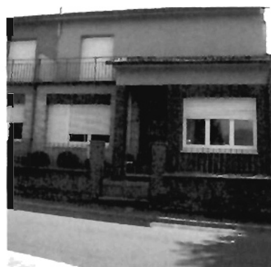
garatge transformat en dormitori en planta baixa
