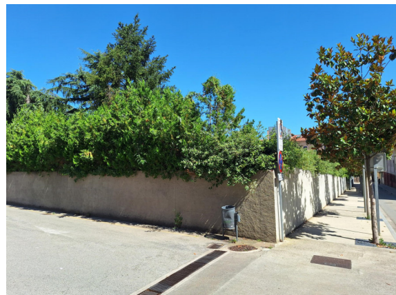
Tanca límit aparcament - pati d'escola.
